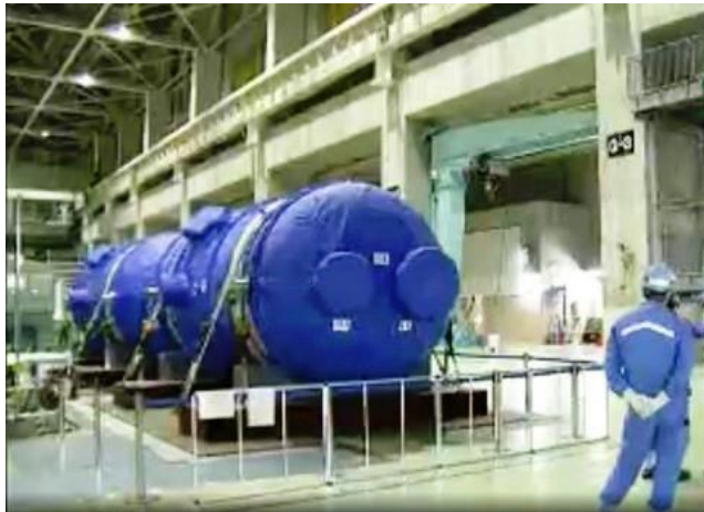
女川原発に導入されたフィルタ装置
