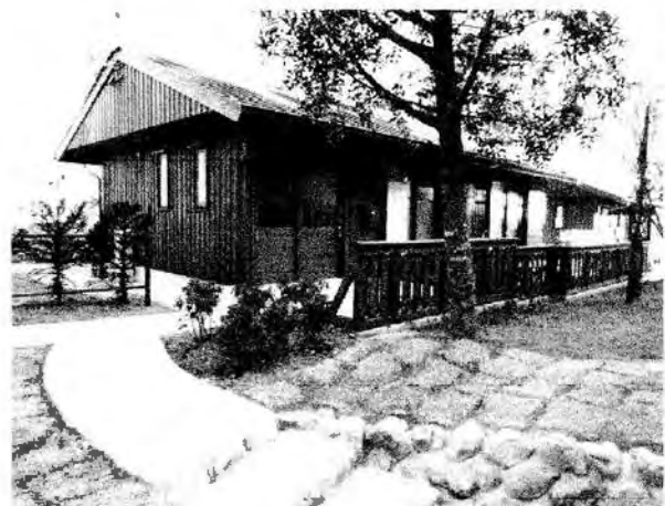
④完成した公営住宅
