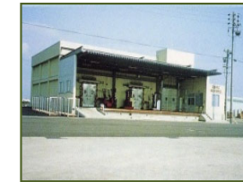
冷凍冷蔵施設
