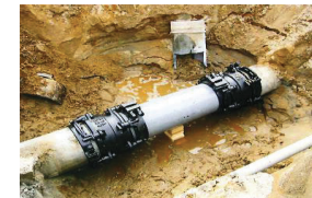
漏水防止のための整備
