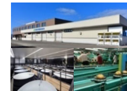
集出荷・貯蔵・加工施設
