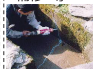
水路のひび割れ補修
