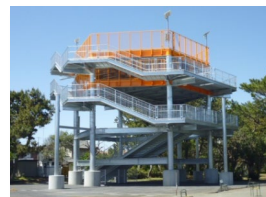
津波避難タワー
