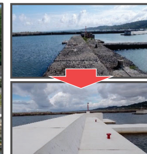
漁港施設の長寿命化対策
