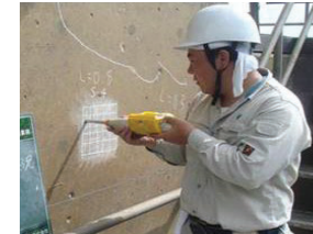
老朽化した施設の機能診断
