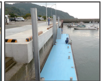
陸揚げの軽労化に資する浮体式係船岸の整備
