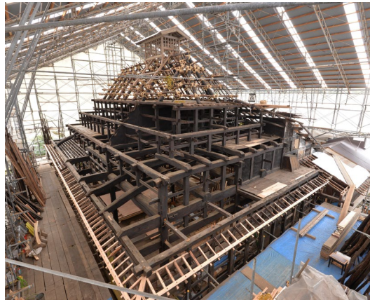
重要文化財 尾崎家住宅主屋ほか8棟 半解体修理の様子（鳥取県）
