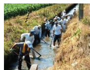
水路の泥上げ
