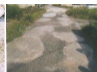
農道の窪みの補修
