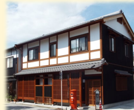
<滋賀県 近江八幡市八幡> 修景事業を実施した建造物
