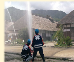
<福島県 下郷町大内宿> 防災事業で整備した放水銃
