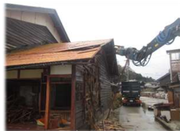
公費解体の様子
