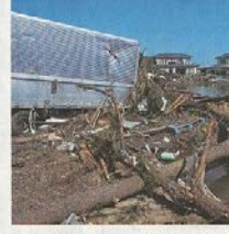
被災現場で発生した大量の瓦礫。大規模災害時のリスク分散が求められる。
