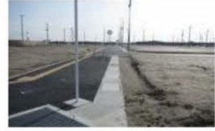
インフラ整備が進む六郷地区 (H27.3撮影)
