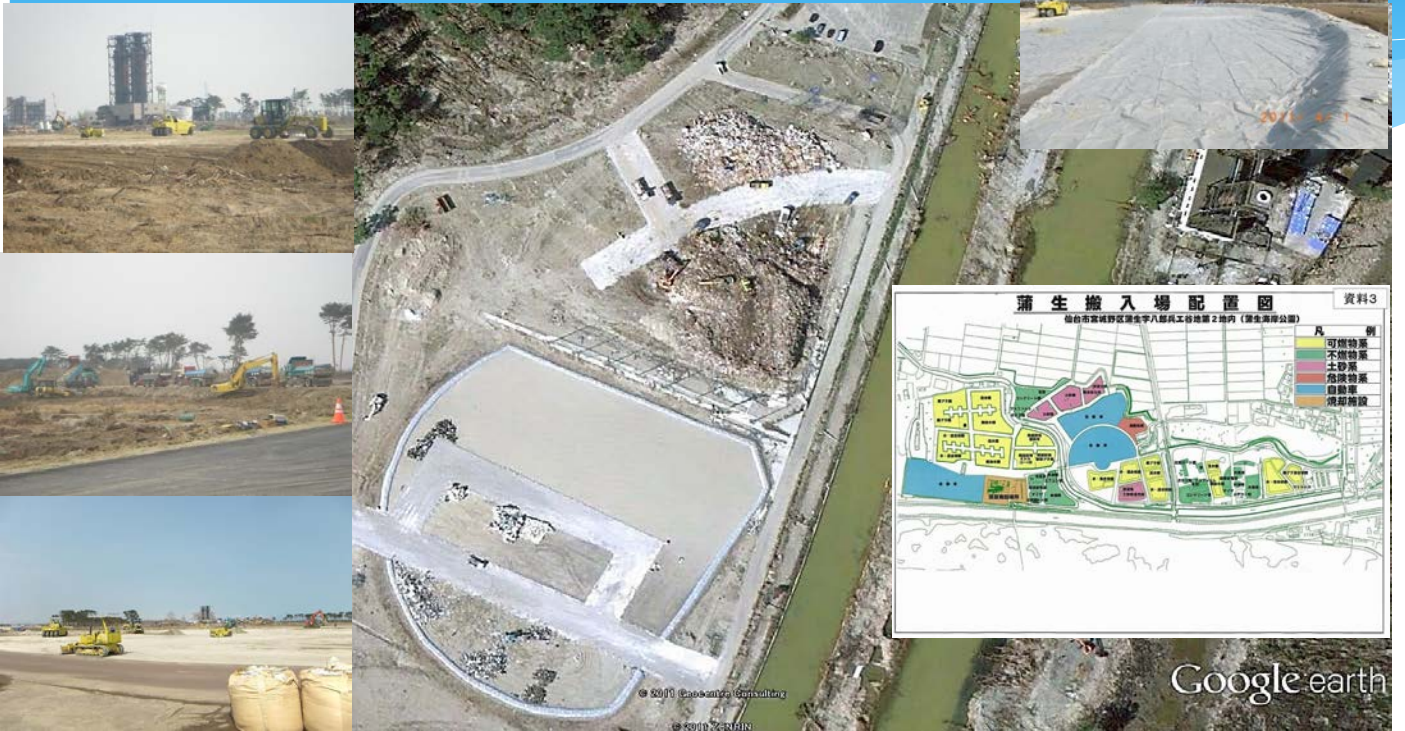
蒲生がれき搬入場造成隊(緊急作業隊) 造成状況
