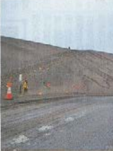
被災現場で発生した大量の瓦礫。大規模災害時のリスク分散が求められる。
