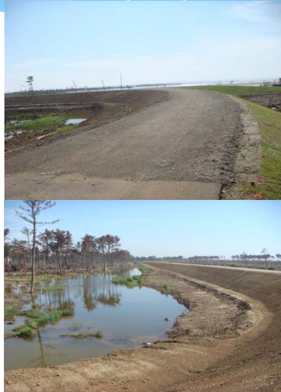
暫定復旧完了写真
