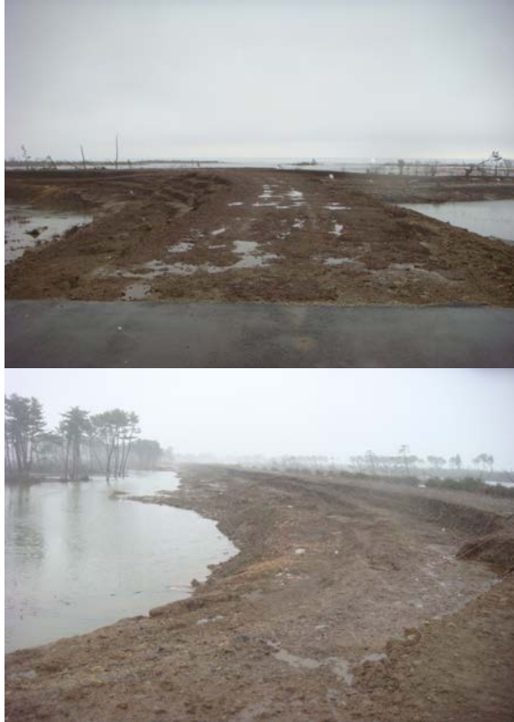
被災状況写真
