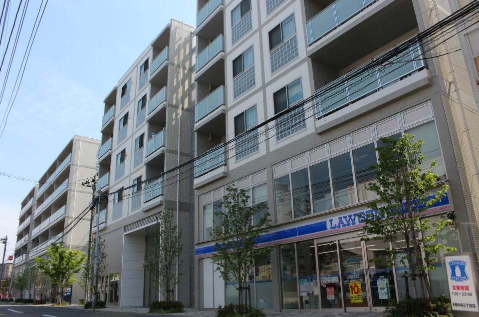
石巻テラス（中央三丁目1番地区／市街地再開発事業／平成28年1月完成）
