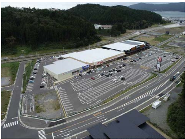
共同利用街区に立地した大型商業施設
