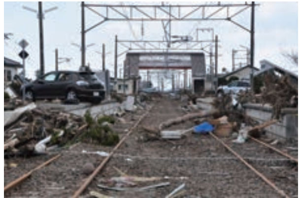
津波被災直後の旧JR山下駅
